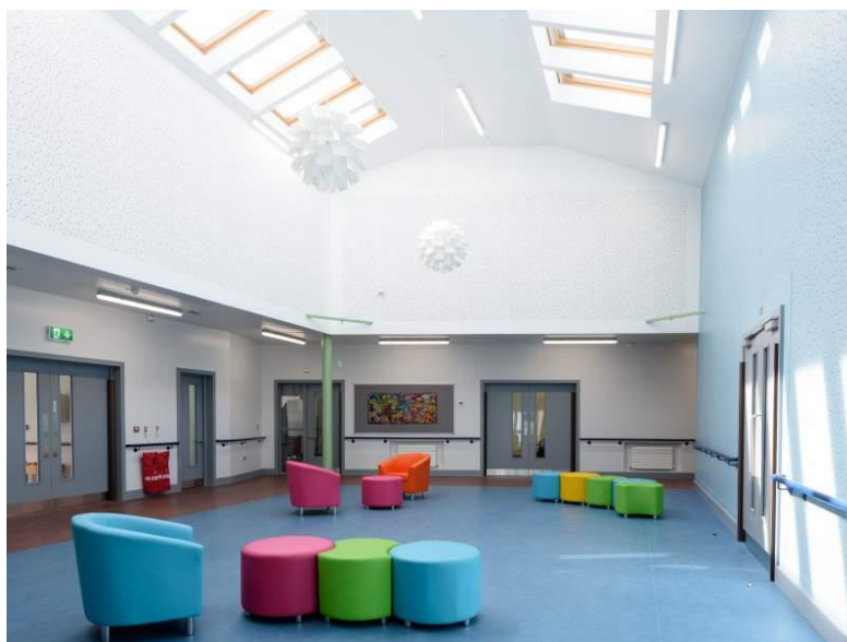
شکل ۱. نحوه به کار گیری نور طبیعی از طریق نورگیرهای سقفی، منبع: (احسانی فر، ۱۳۹۹)
